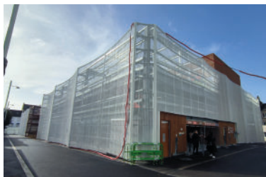
Parking en élévation
